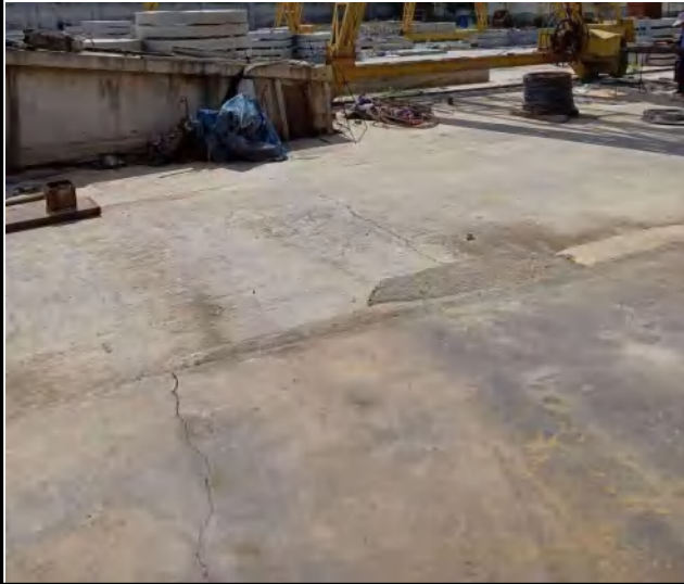
租赁厂区现状
