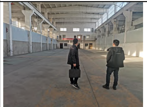
项目负责人现场勘查
