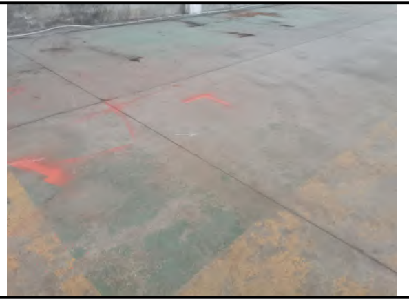
车间硬化路面
