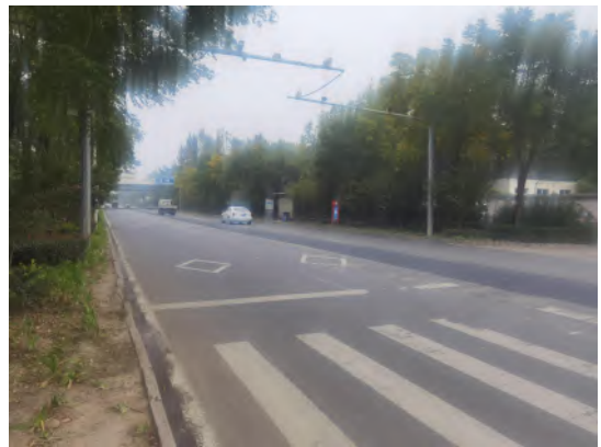
项目厂区南侧的滨河北路
